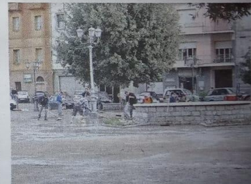
Lavori dopo l'alluvione del novembre 2020 a Bitti
